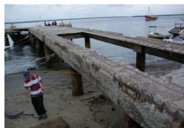
写真 機能を喪失した栈橋の例
