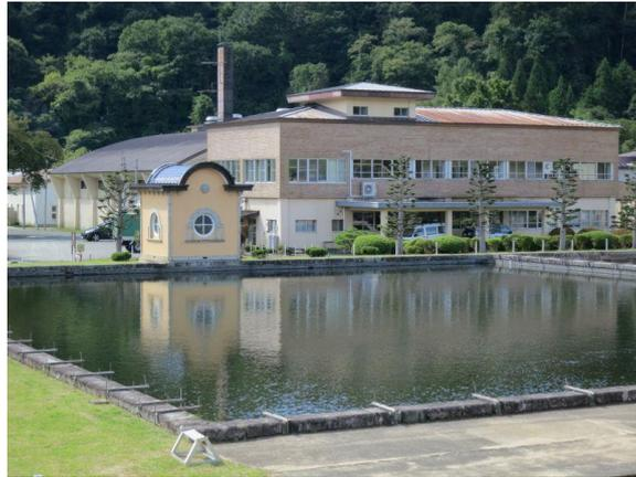
図 2 米内浄水場の緩速ろ過池
