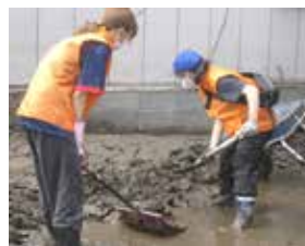
久慈市街地での泥上げ作業 (9月3日)
