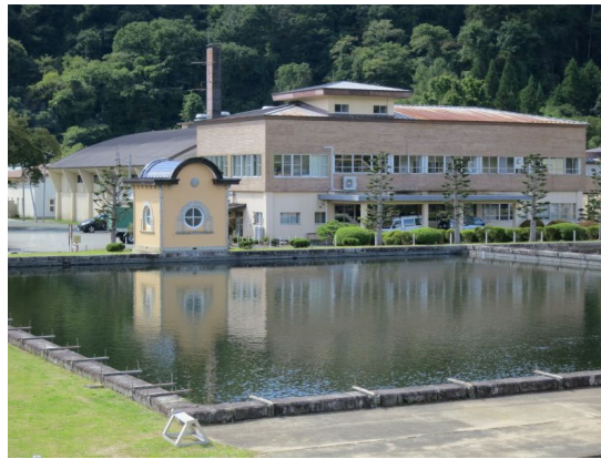
図 1 米内浄水場の緩速ろ過池
